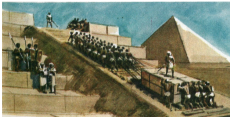
Строительство пирамиды. На деревянных полозьях каменный блок тащат вверх. Рисунок нашего времени.
