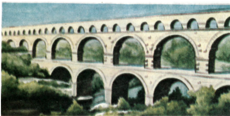
Римский арочный мост в Галлии (современной Франции). По мосту проходил водопровод. Высота моста над уровнем реки почти 50 метров.
