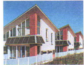
Рис. 279. Фотоэлектрические установки на домах
